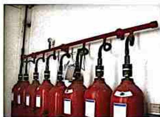
รูปที่ 28 ภาพแสดงอุปกรณ์ตรวจจับความร้อนและควันพร้อมระบบ CO_2
