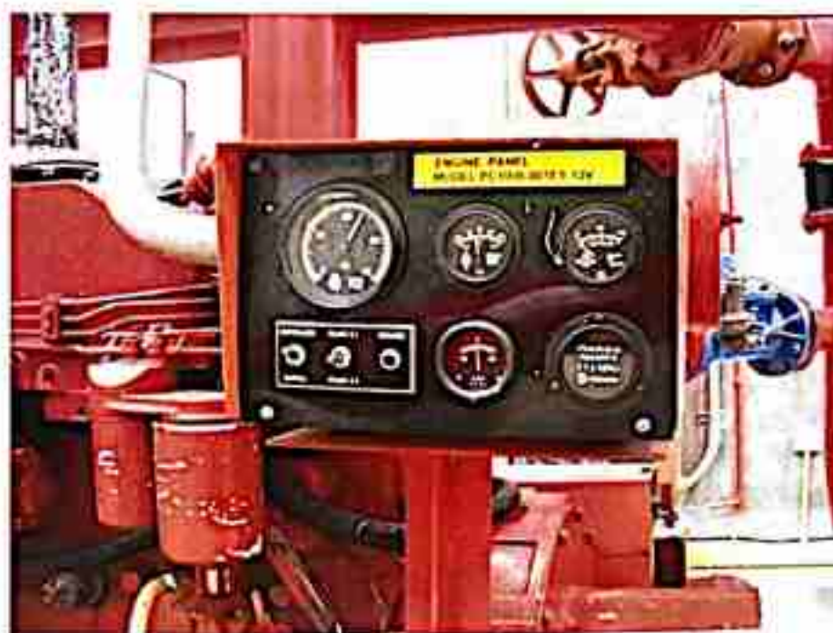
รูปที่ 9 ภาพแสดงป้อนน้ำระบบดับเพลิงประจำคลังน้ำมัน
