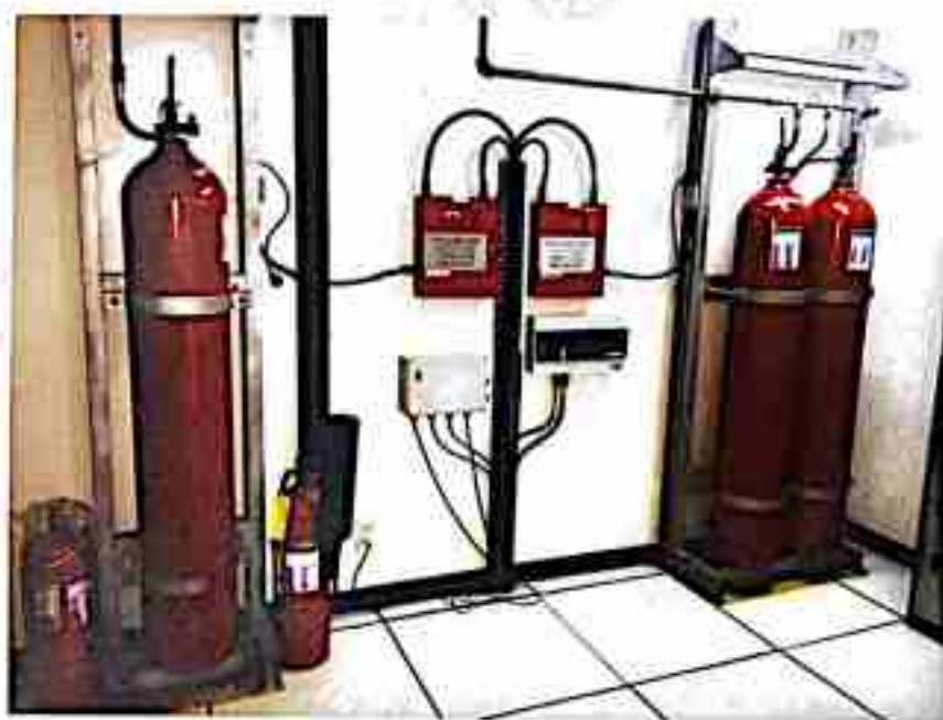
รูปที่ 35 ภาพแสดงตู้ควบคุมและระบบดับเพลิงชนิด CO 2
