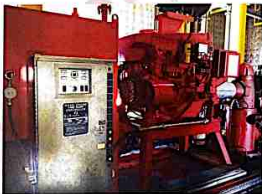
รูปที่ 33 ภาพระบบปั้มน้ำดับเพลิงของท่าเทียบเรือ
