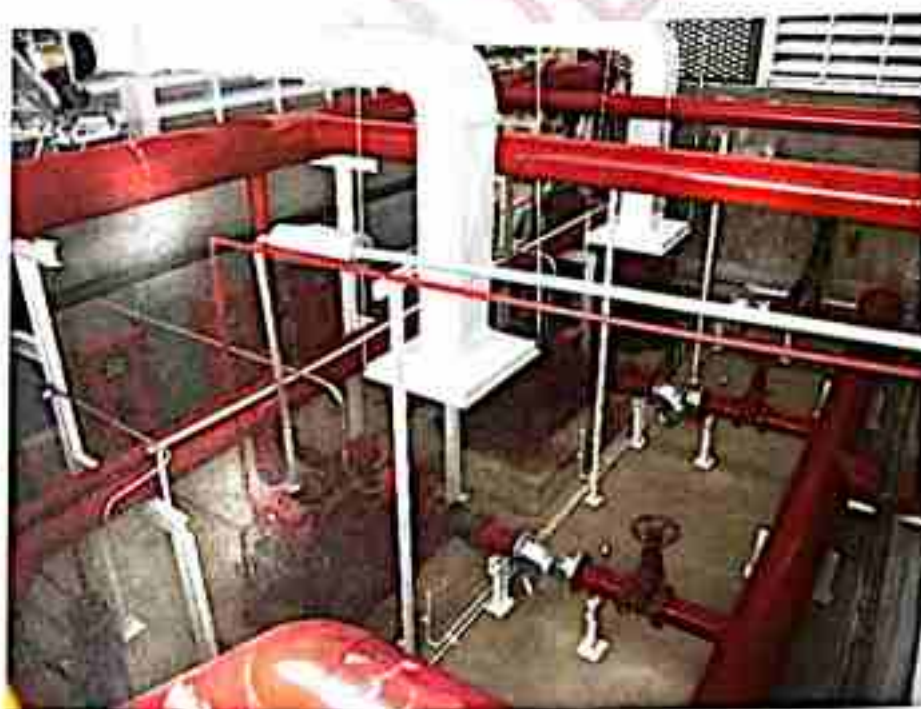
รูปที่ 10 ภาพแสดงป้อนและระบบท่อน้ำดับเพลิงภายในห้องระบบป้อนดับเพลิง
