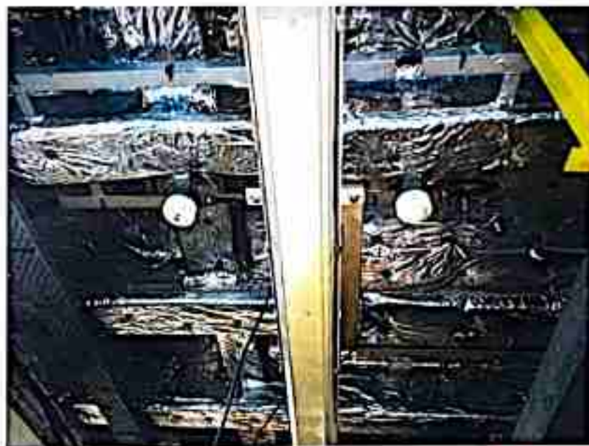
รูปที่ 32 ภาพแสดงอุปกรณ์ตรวจสอบความร้อนและควันของท่าเทียบเรือ
